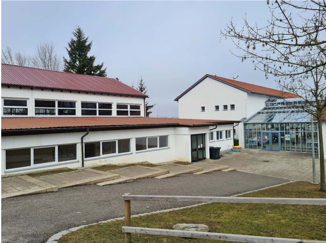
Bestehendes Schulgebäude, die alte Turnhalle (links) soll abgerissen werden. In diesem Bereich werden Parkplätze geplant.
